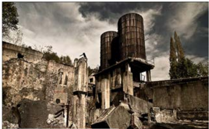
Figura 11. Instalaciones de la Mina de Mercurio el Terronal
