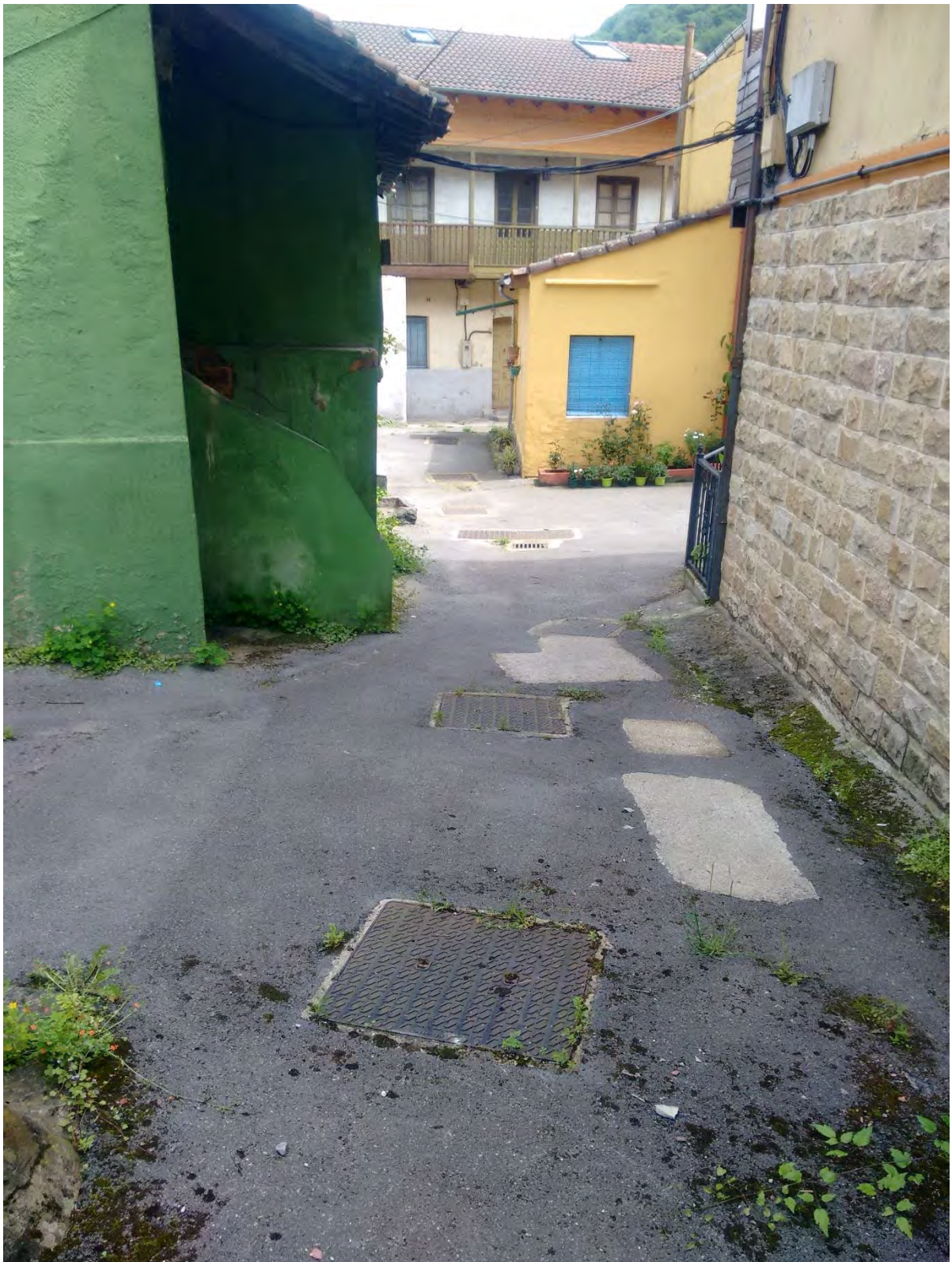
Imagen 24. Canalización de un arroyo en la calle que pasa frente a la vivienda situada en El Lluarín, 14.
