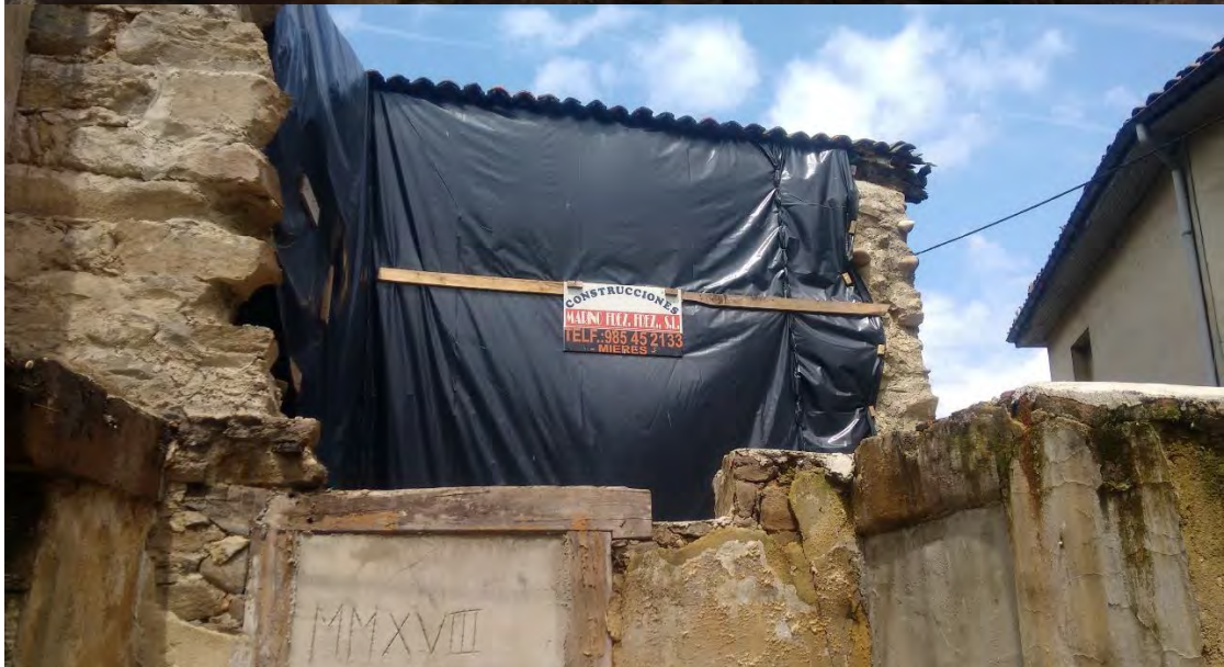
Imagen 6. Proceso y resultados de la instalación de una lona protectora sobre las pinturas.
