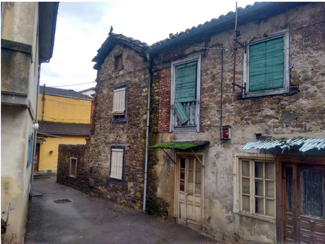
Imagen 5. Vistas del inmueble tras las obras de demolición y de las edificaciones colindantes.
