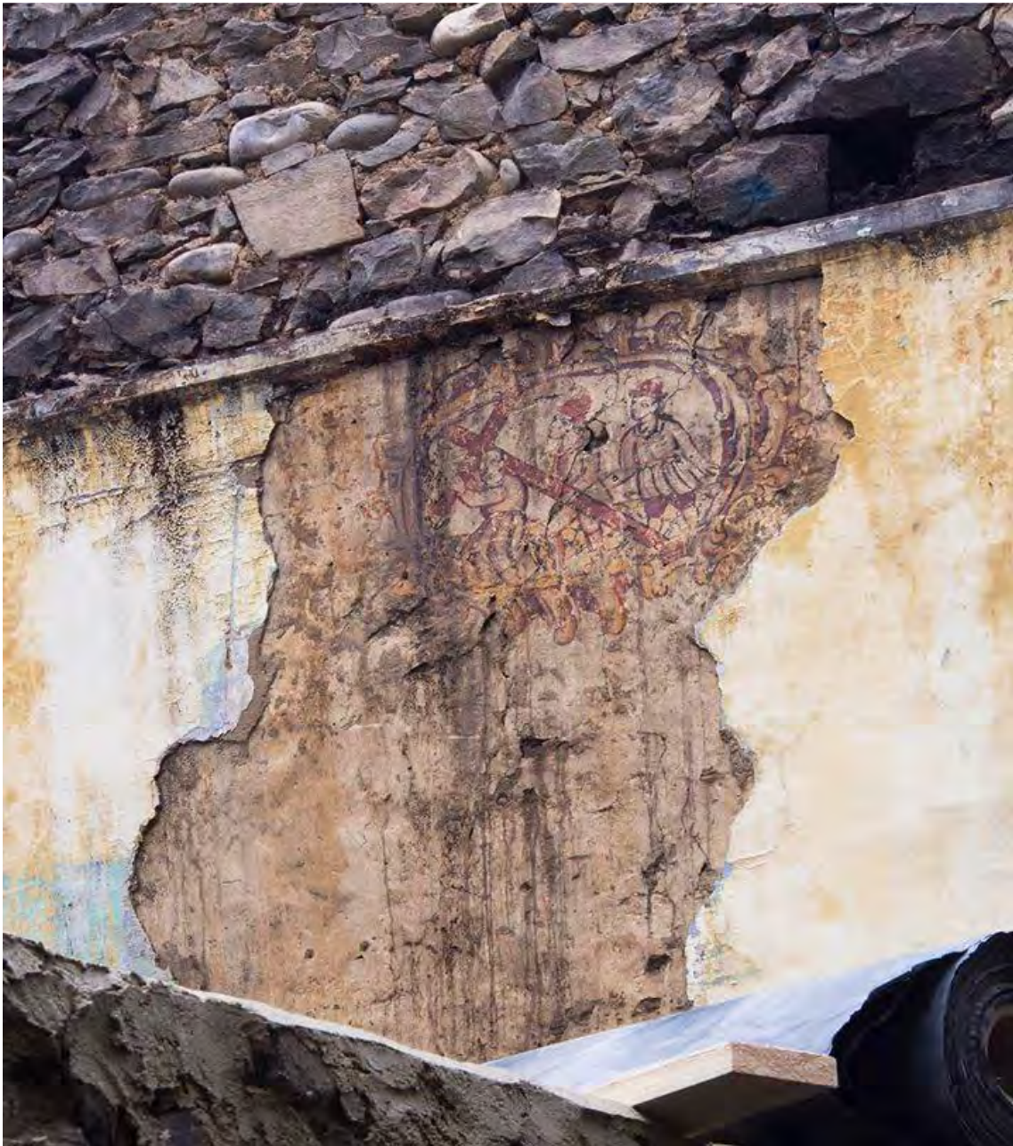
Imagen 8. Zona en la que se ha desprendido gran parte de la capa de revoco moderno bajo la primera escena, en la que no se observan representaciones a menor altura.
