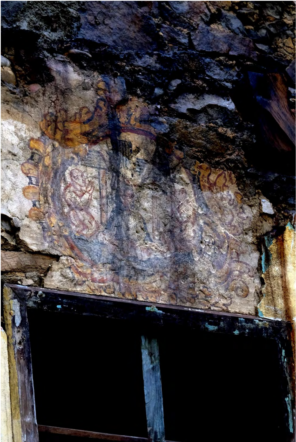
Imagen 11. La segunda escena está situada sobre un vano y presenta numerosos daños.
