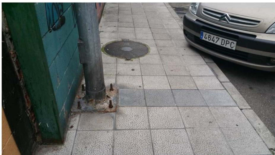
**Foto 12:** Conexión a Red de Alumbrado. Luminaria existente se colocará en nuevo punto doble. Columna de la foto a retirar .
