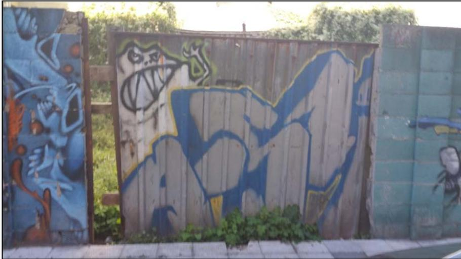
**Foto 9:** Vista exterior donde existe un portón que se retirará y se colocará ladrillo de bloque como el existente en el muro
