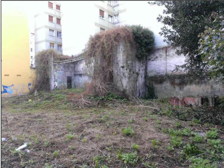
**Foto 5:** Vista de la zona con sobre excavación, Demoler escenario manteniendo las paredes salientes como contrafuertes.
