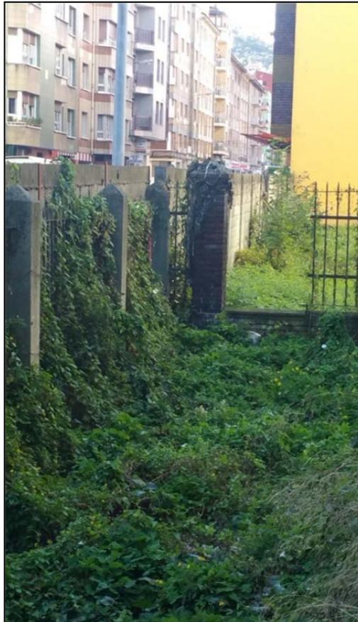
**Foto 4:** Cercado interior a demoler (Rejas, Pilastras y muro interior). Desbroce en toda la parcela
